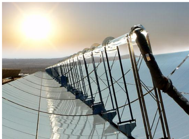
24. ábra: Napteknő (forrás: http://www.origo.hu/tudomany/20070709-nevada-solar-one-hatalmas-termikus-naperomu.html [2016.11.10.]
